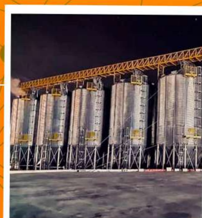
Obra realizada em Recife-PE
