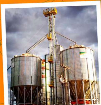
Obra realizada em Lagoa Formosa - MG
